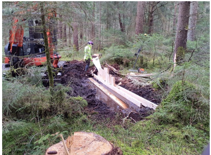
Mit einem Spezialbagger werden Holzspundwände gesetzt. Foto: LPV Lindau
